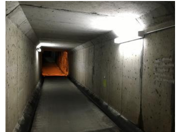
改善後（地下道内部）
