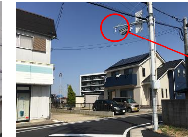
対策後(支柱からの距離を短く調整)
